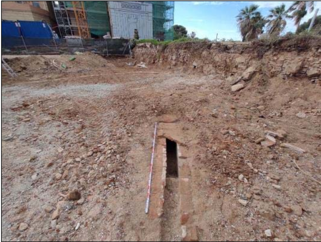
17. Imatge del final de la canalització (UE102), on observem part de la coberta, des de l'oest.
