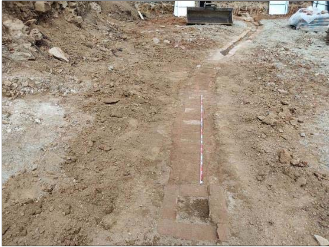
19. Fotografia de detall de la caixa de registre final de la conducció (UE105), des de l'est.
