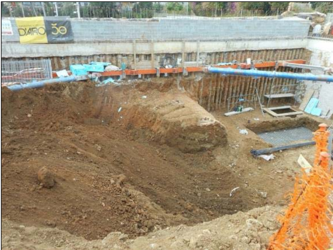
56. Tasques de rebaix de terreny de la tercera fase, orientació oest.
