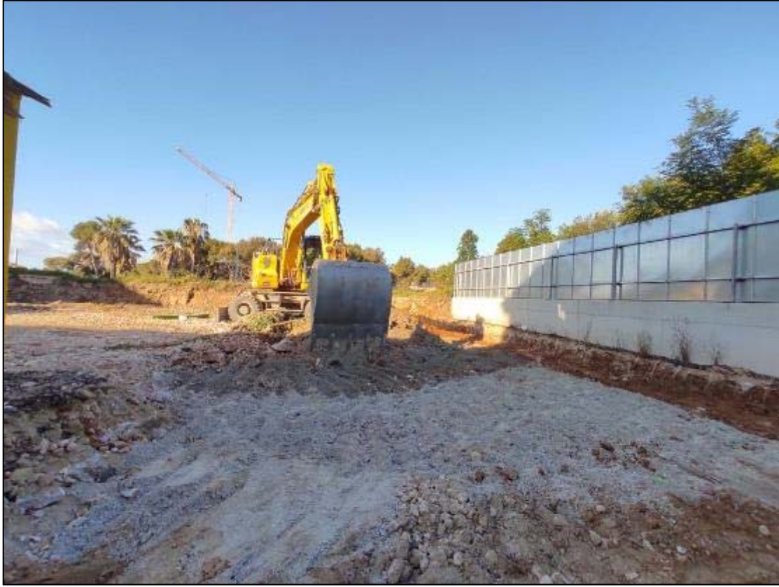
3. Vista de les tasques inicials de rebaix del terreny, des del nord.
