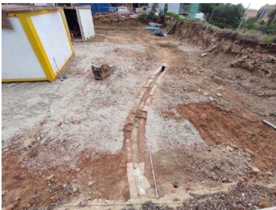
Vista general de la canalització (UE102) des de l'oest. (Foto: Òscar Matas).
