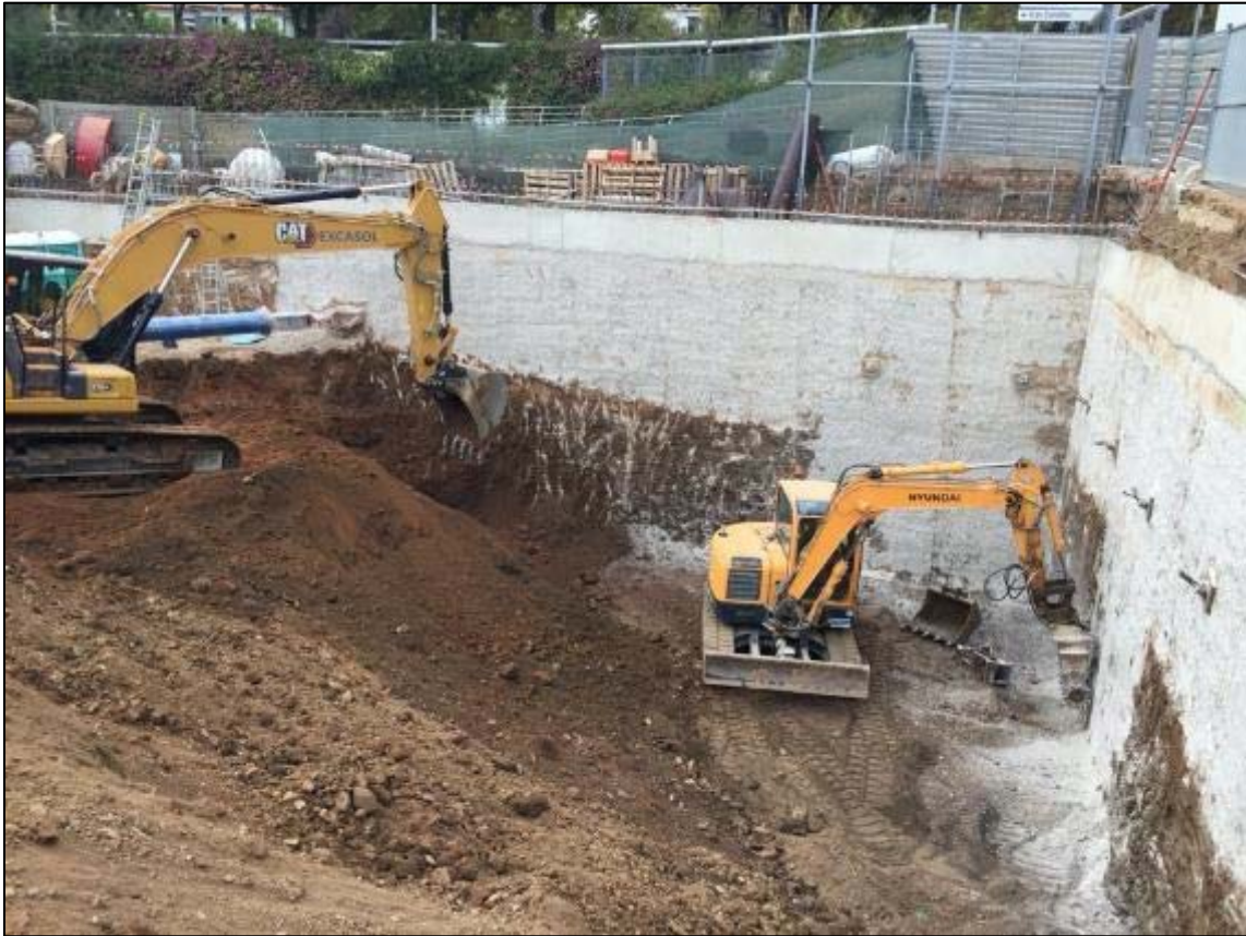
43. Tasques de rebaix de terreny de la tercera fase, orientació nord.
