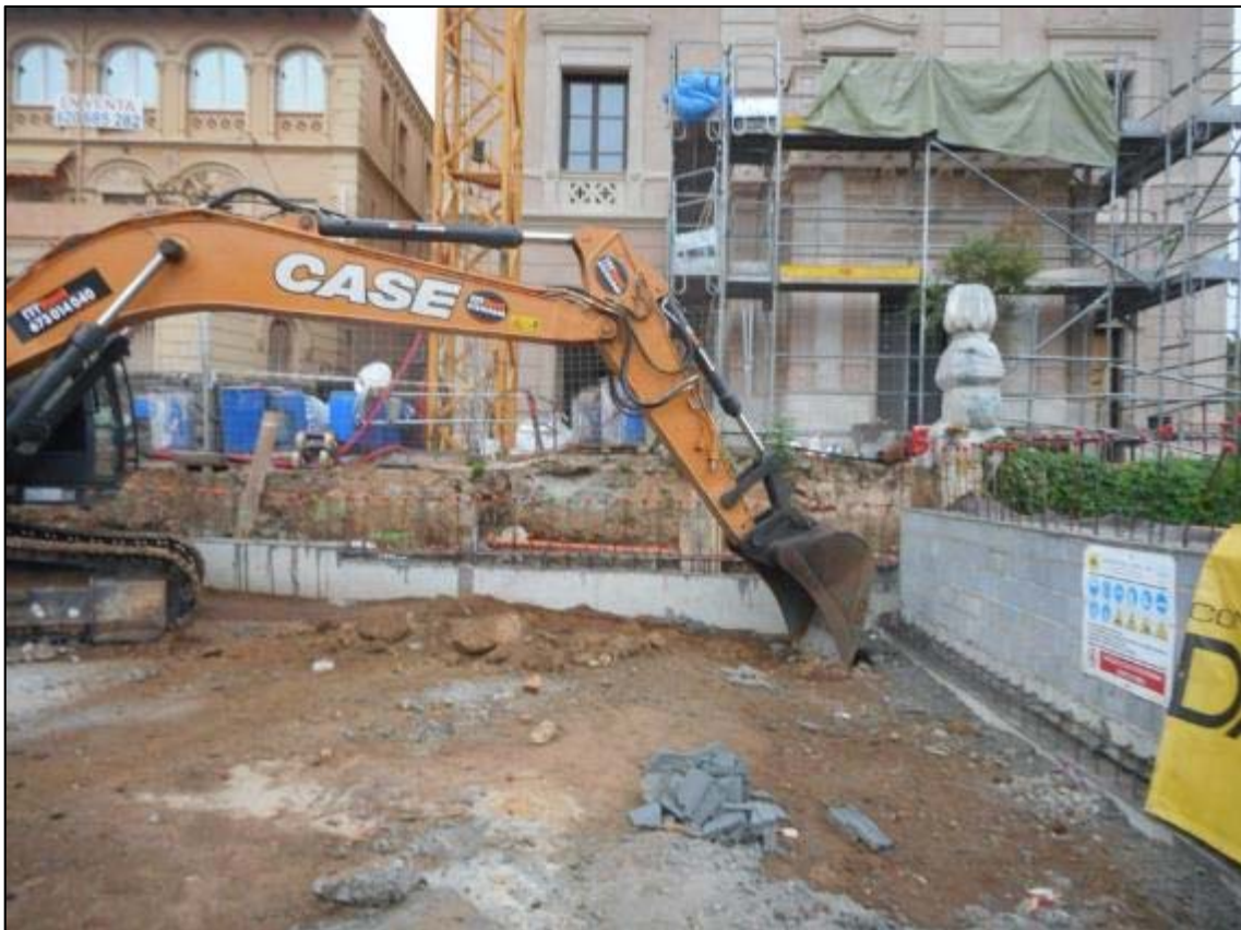
24. Inici dels treballs de buidat i extracció de terres del solar en la segona fase.
