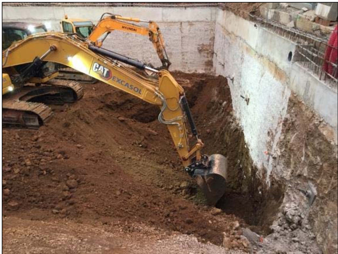
36. Inici de les tasques de rebaix de terreny de la tercera fase, orientació nord.
