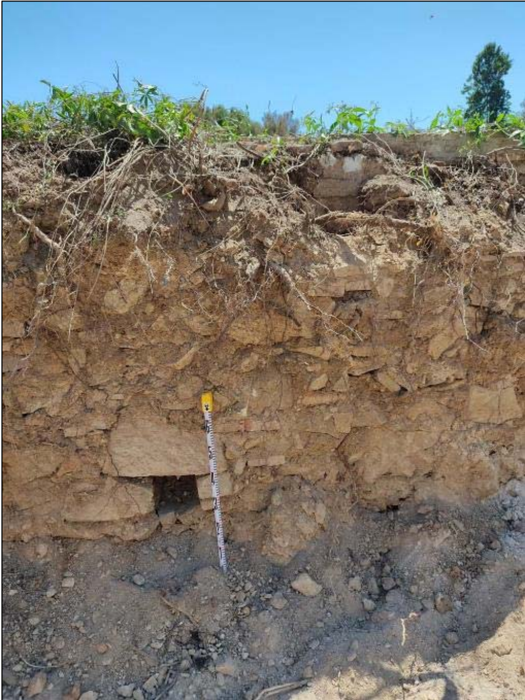
14. Imatge de detall del forat de drenatge quadrangular (UE113) obert al mur de contenció (UE107), des del nord.
