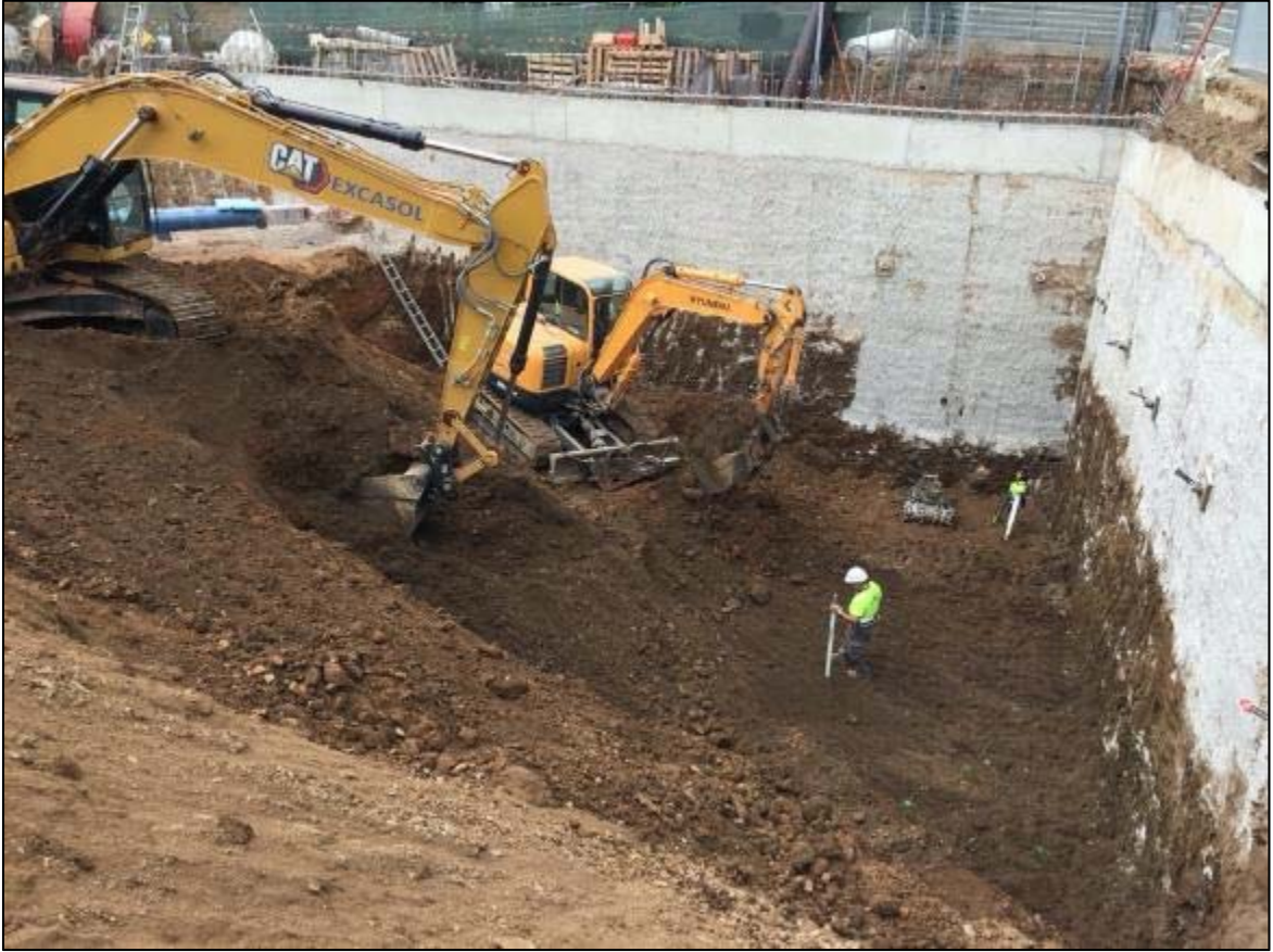
39. Tasques de rebaix de terreny de la tercera fase, orientació nord.
