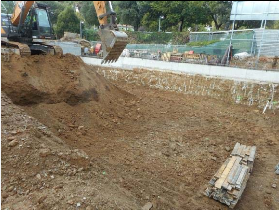
27. Treballs d'extracció de terres del solar en la segona fase, orientació nord.
