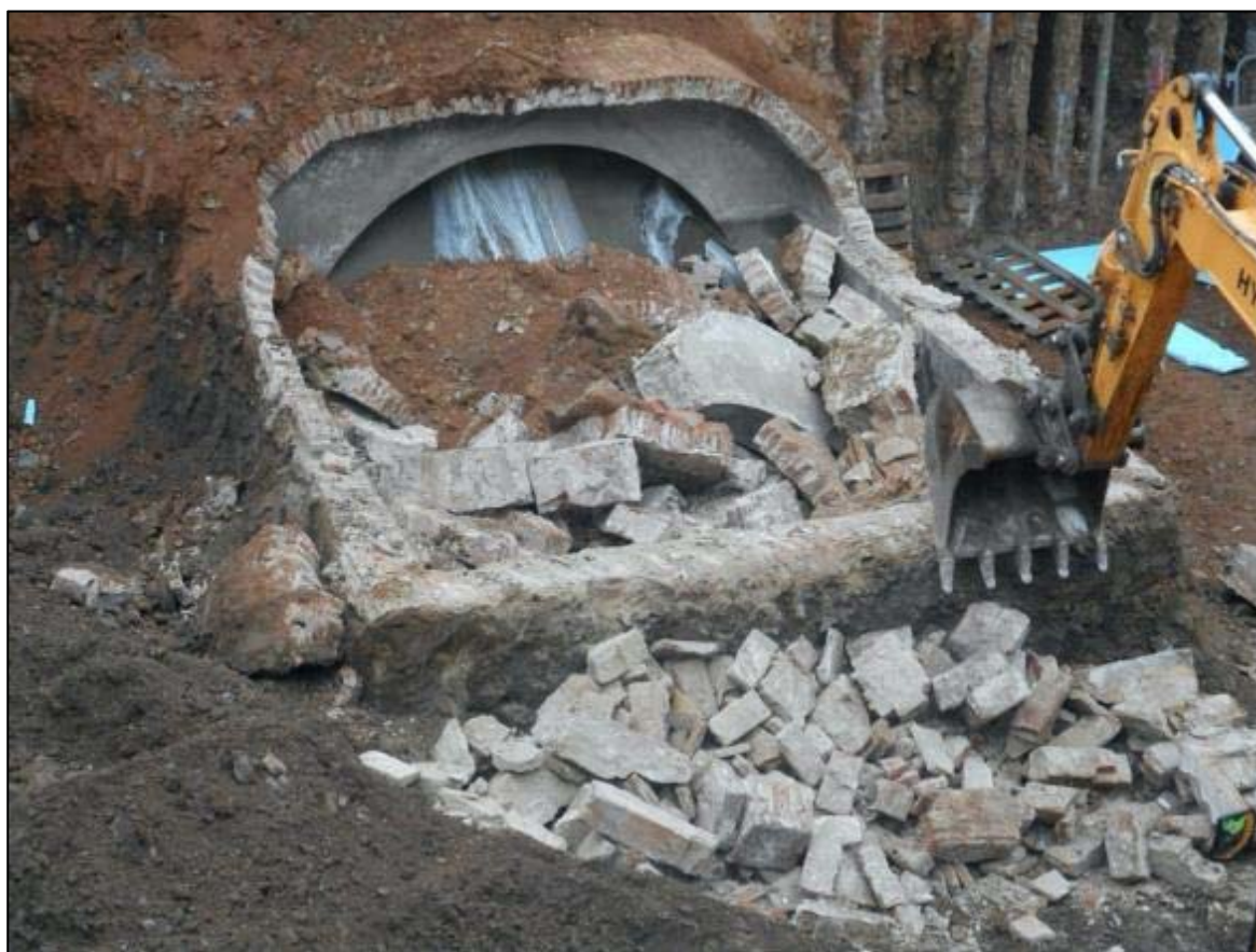
60. Tasques d'enderroc de l'estructura UE 008.
