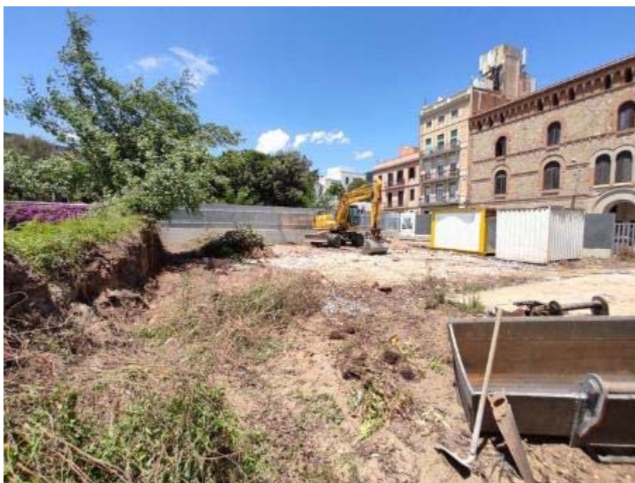
Imatge inicial de la parcel·la, abans de començar els moviments de terres, des de la banda sud-est. (Foto: Òscar Matas).
