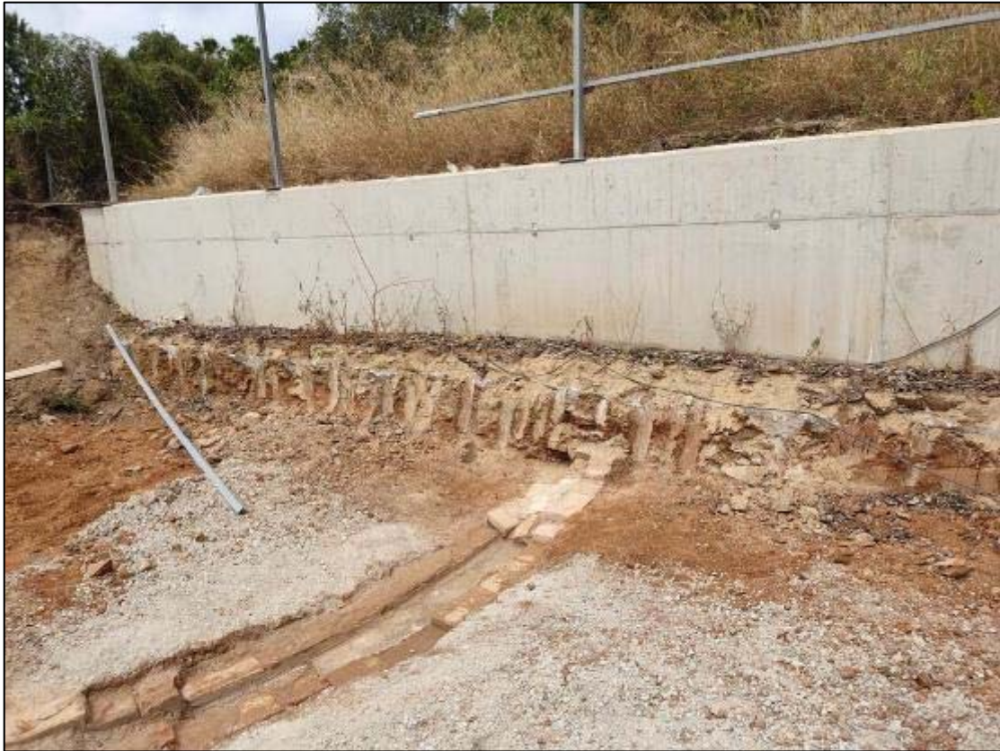
15. Vista de la situació de l'inici de la canalització (UE102), al límit oest del solar, des del nord-est.
