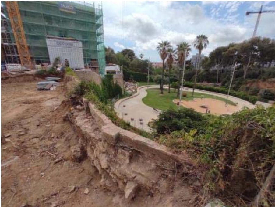
Vista del mur de contenció (UE107) des de l'oest, al solar objecte de la intervenció arqueològica (Foto: Òscar Matas).
