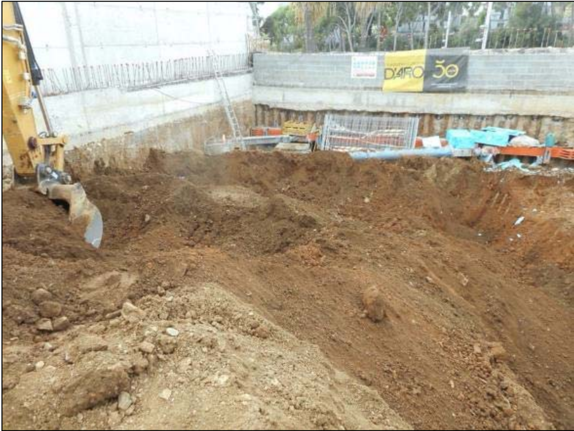
57. Tasques de rebaix de terreny de la tercera fase, orientació sud-oest.
