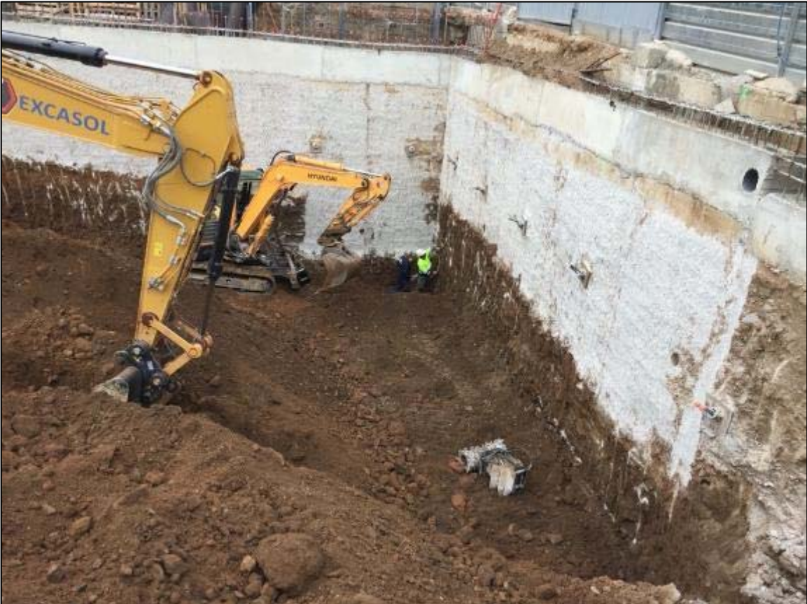
38. Tasques de rebaix de terreny de la tercera fase, orientació nord.
