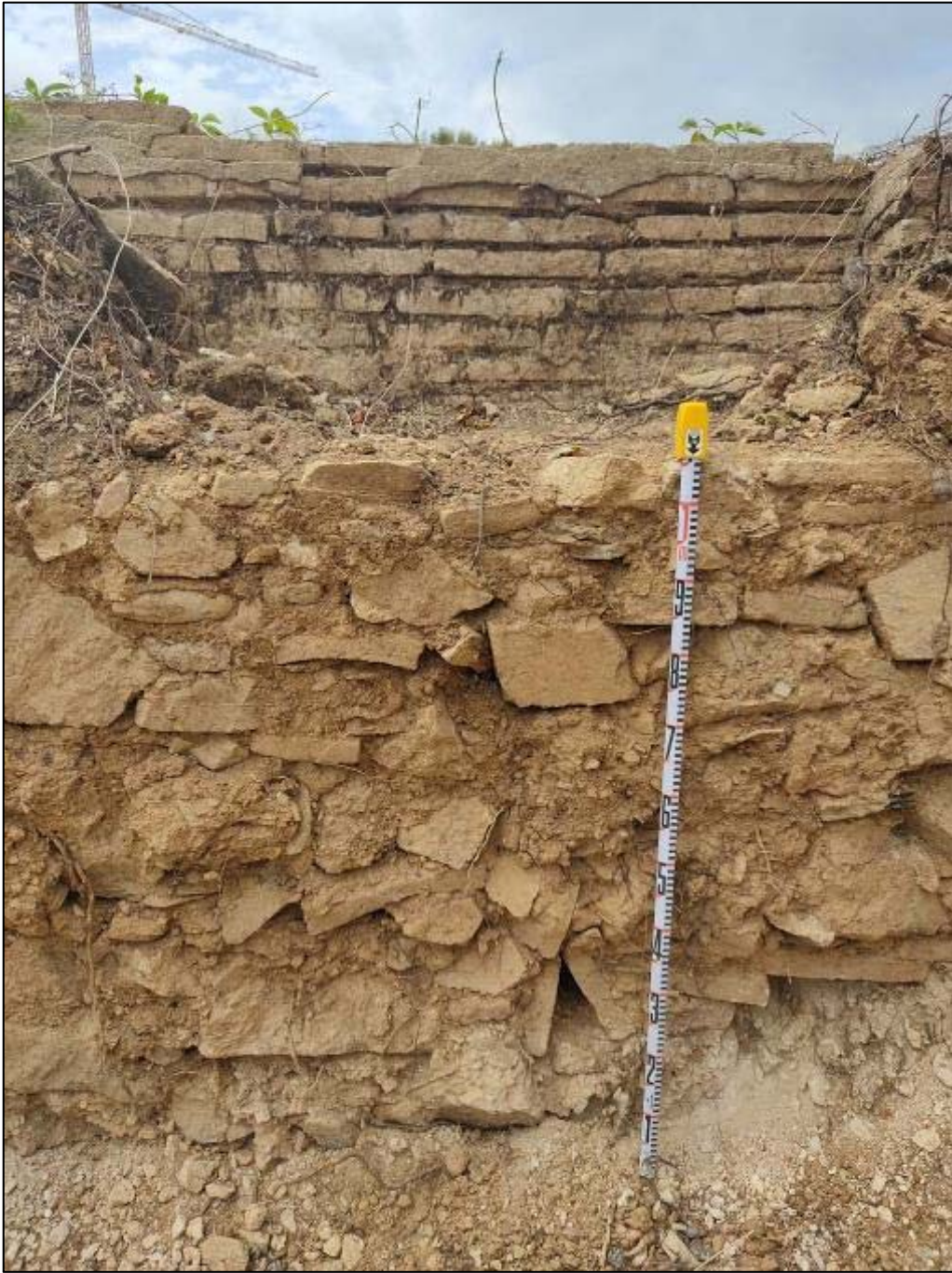
13. Vista general d'un dels forats de drenatge (UE117) obert al mur de contenció (UE107), des del nord.
