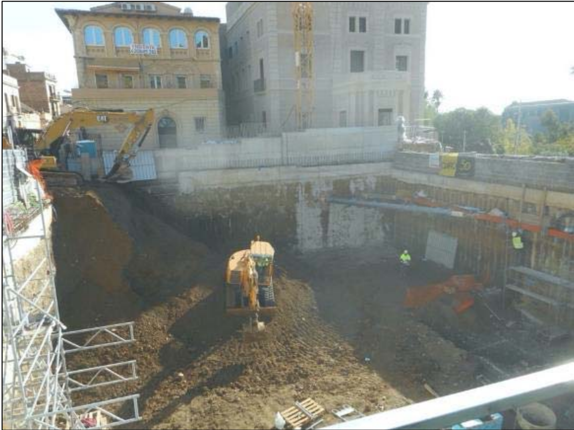
65. Tasques finals de rebaix de terreny de la tercera fase, orientació sud-oest.
