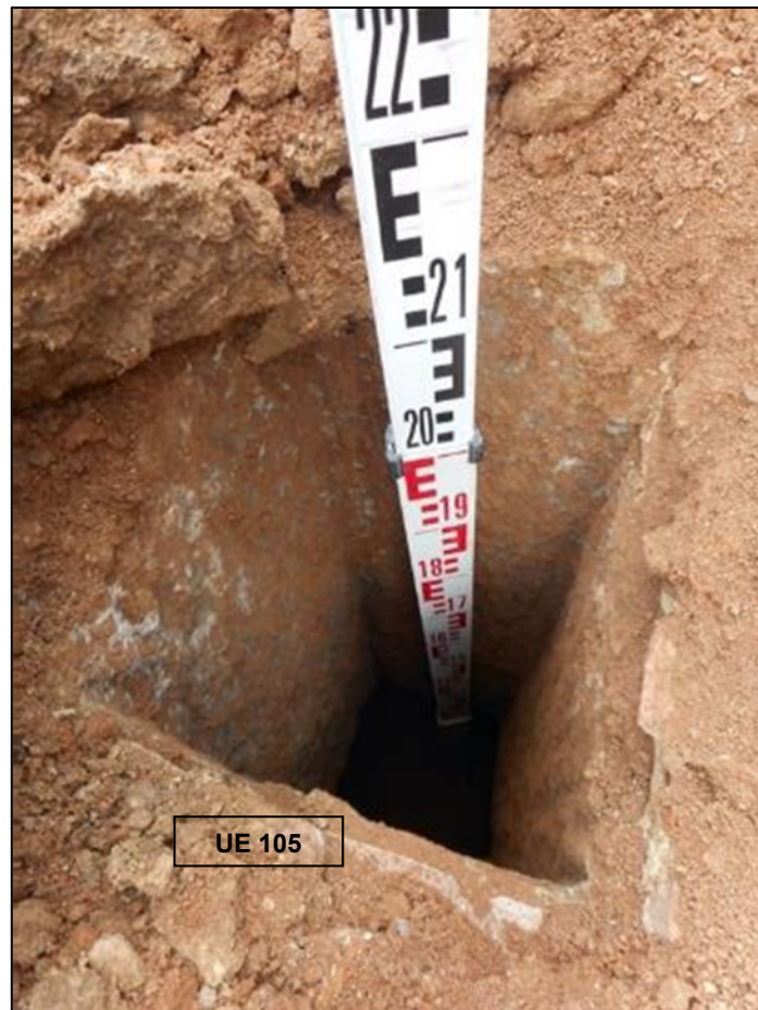
31. Localització d'un baixant UE 105 obrat amb maons i morter.
