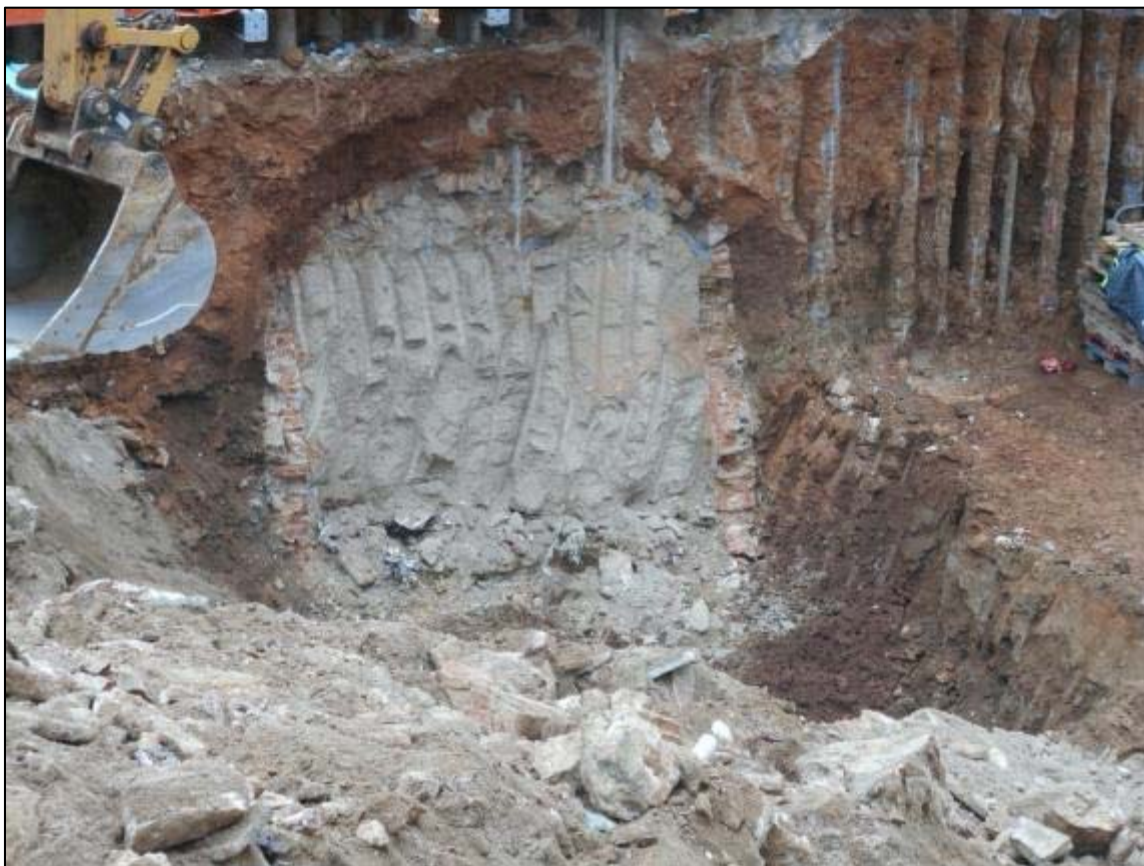
61. Tasques d'enderroc de l'estructura UE 008.
