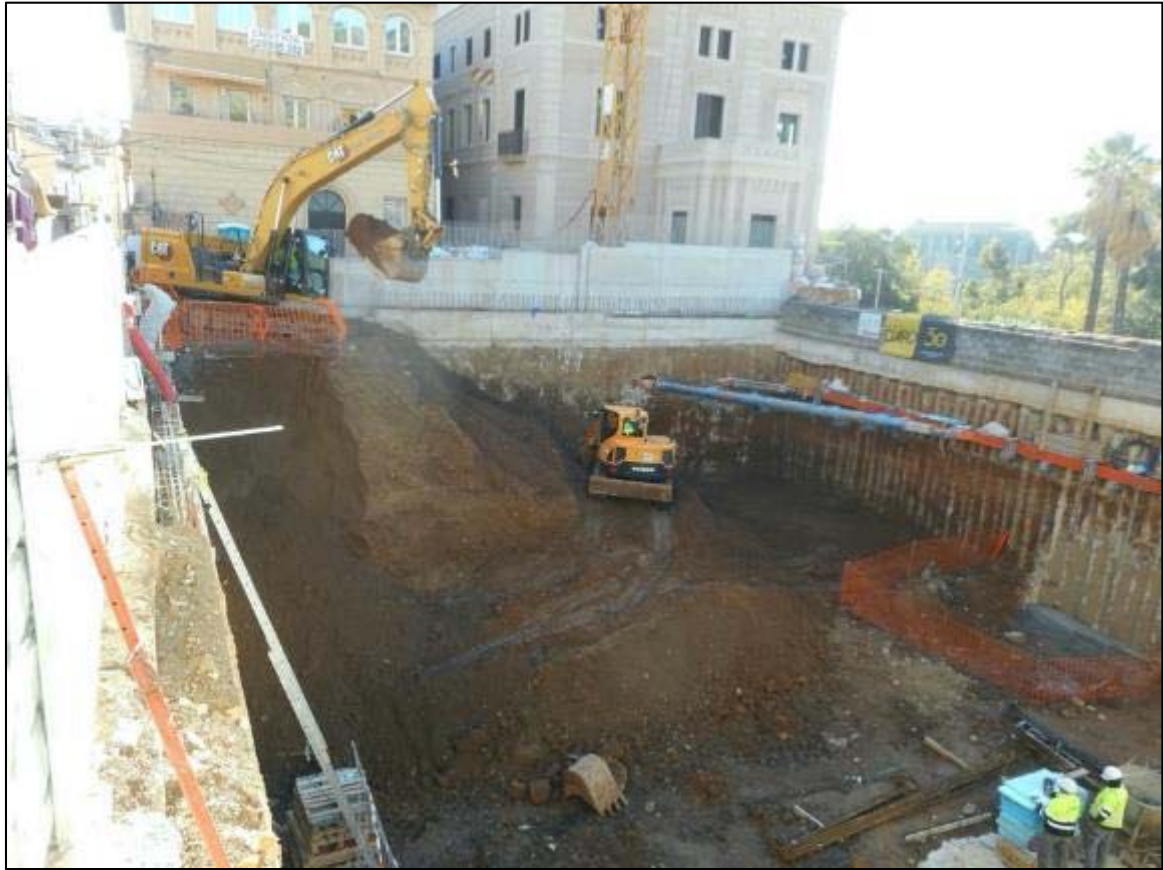
63. Tasques finals de rebaix de terreny de la tercera fase, orientació sud-oest.
