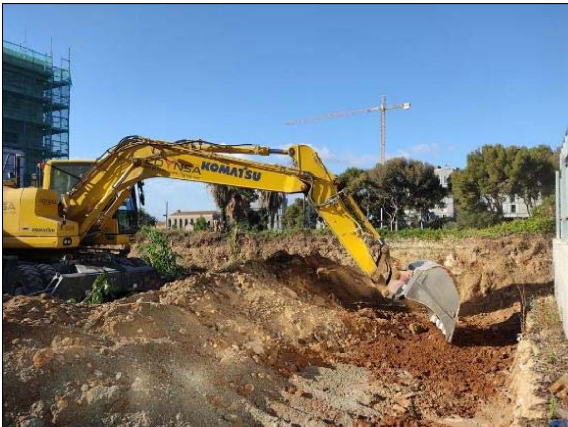
4. Fotografia dels primers rebaixos del terreny, des del nord-oest.
