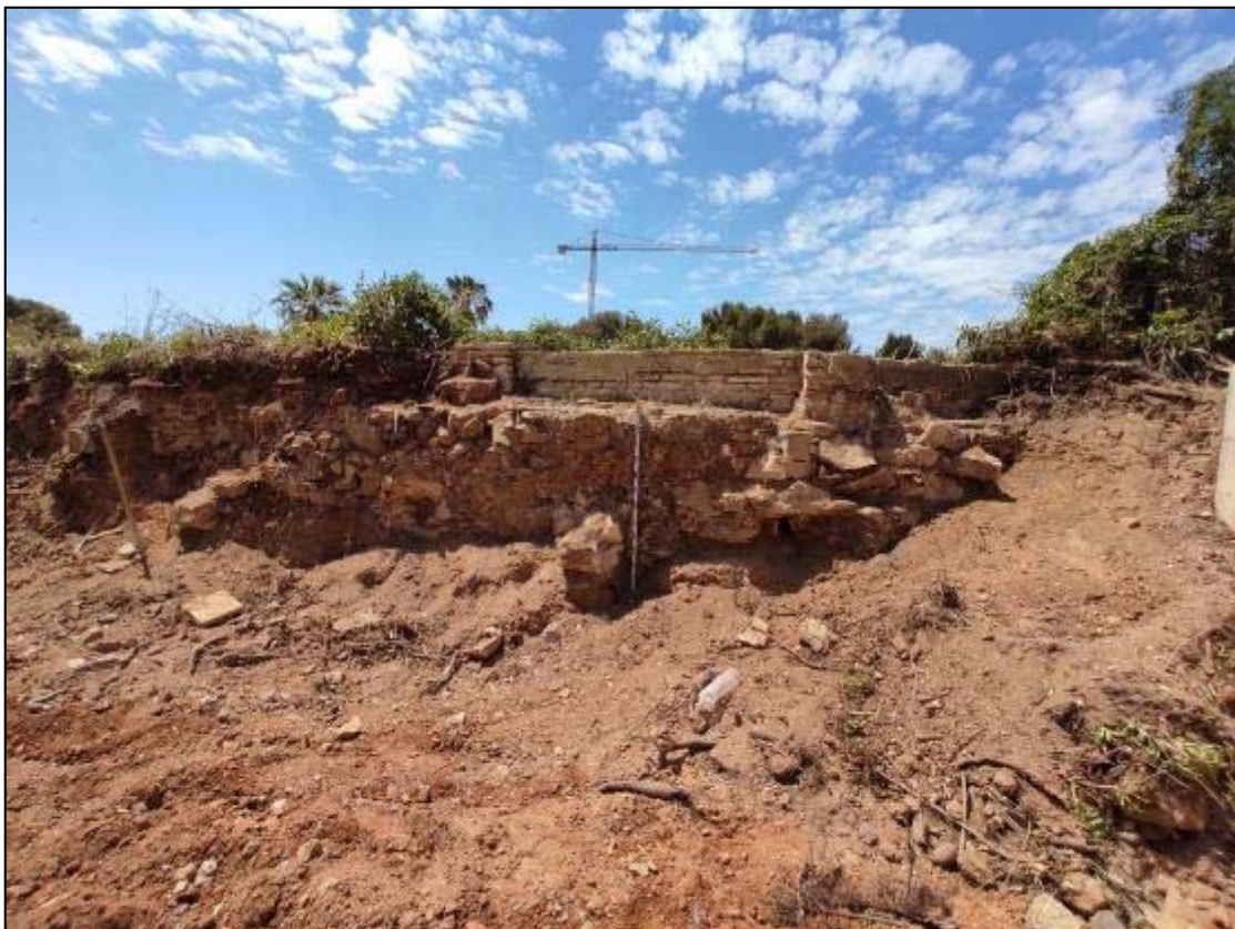
10. Una altra vista general de la banda occidental interior del mur de contenció (UE107), des del nord.
