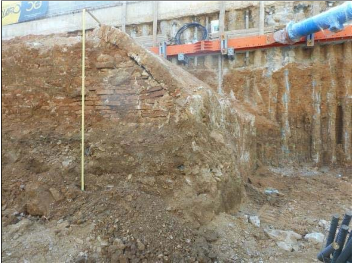
51. Detall del parament nord-est de l'estructura UE 008.
