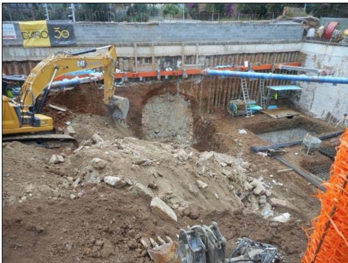
62. Tasques d'enderroc de l'estructura UE 008.
