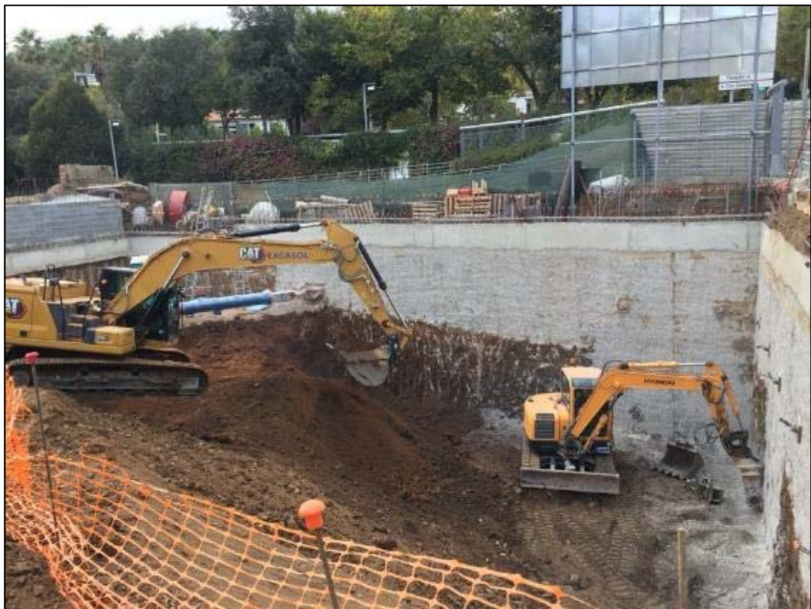
44. Tasques de rebaix de terreny de la tercera fase, orientació nord.
