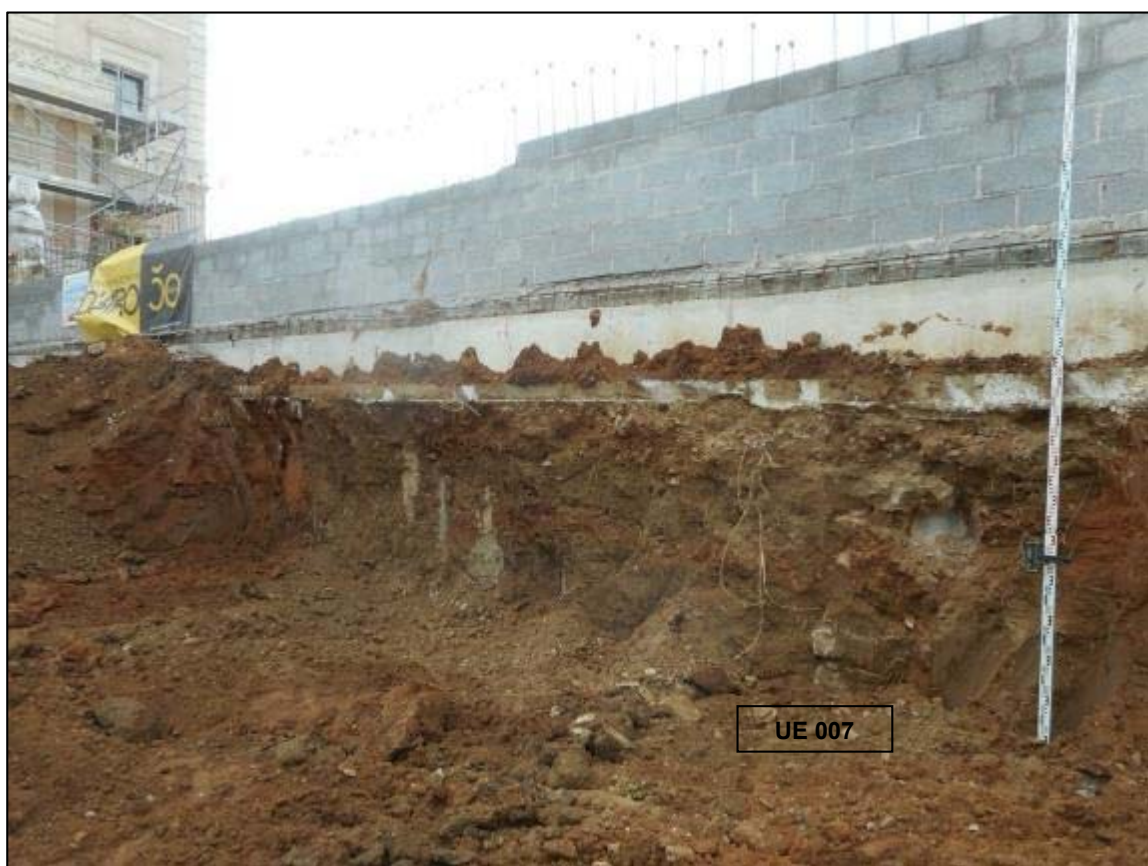
30. Treballs d'extracció de terres del solar en la segona fase, orientació oest.
