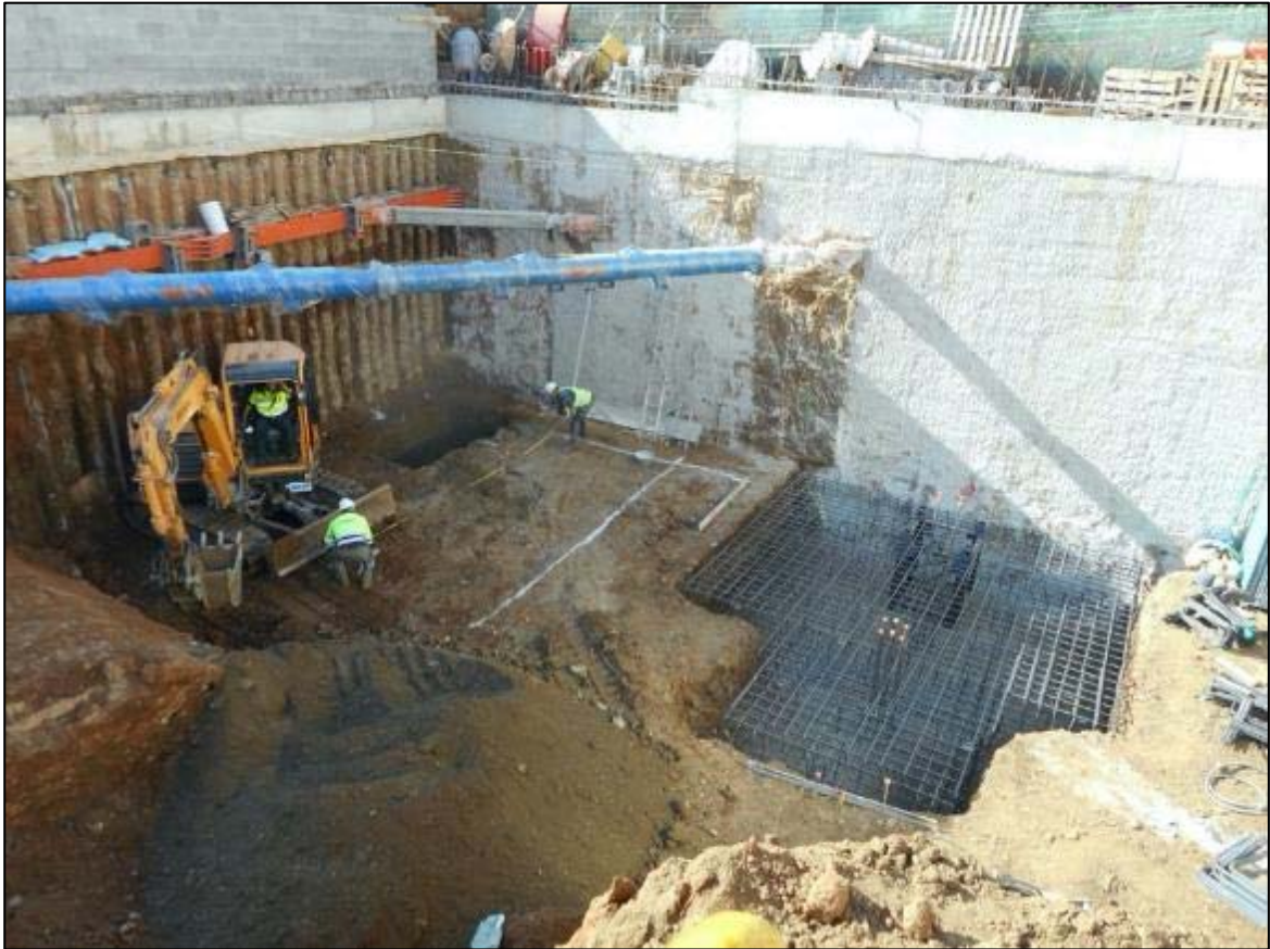
47. Tasques de rebaix de terreny de la tercera fase, orientació nord.
