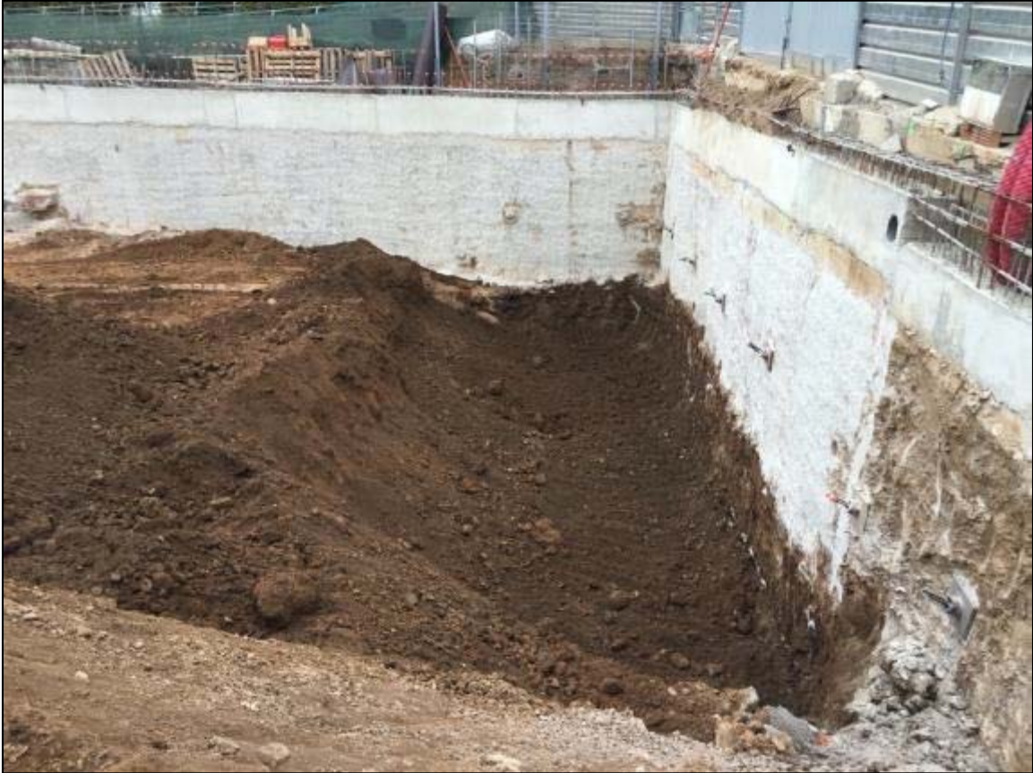
37. Tasques de rebaix de terreny de la tercera fase, orientació nord.
