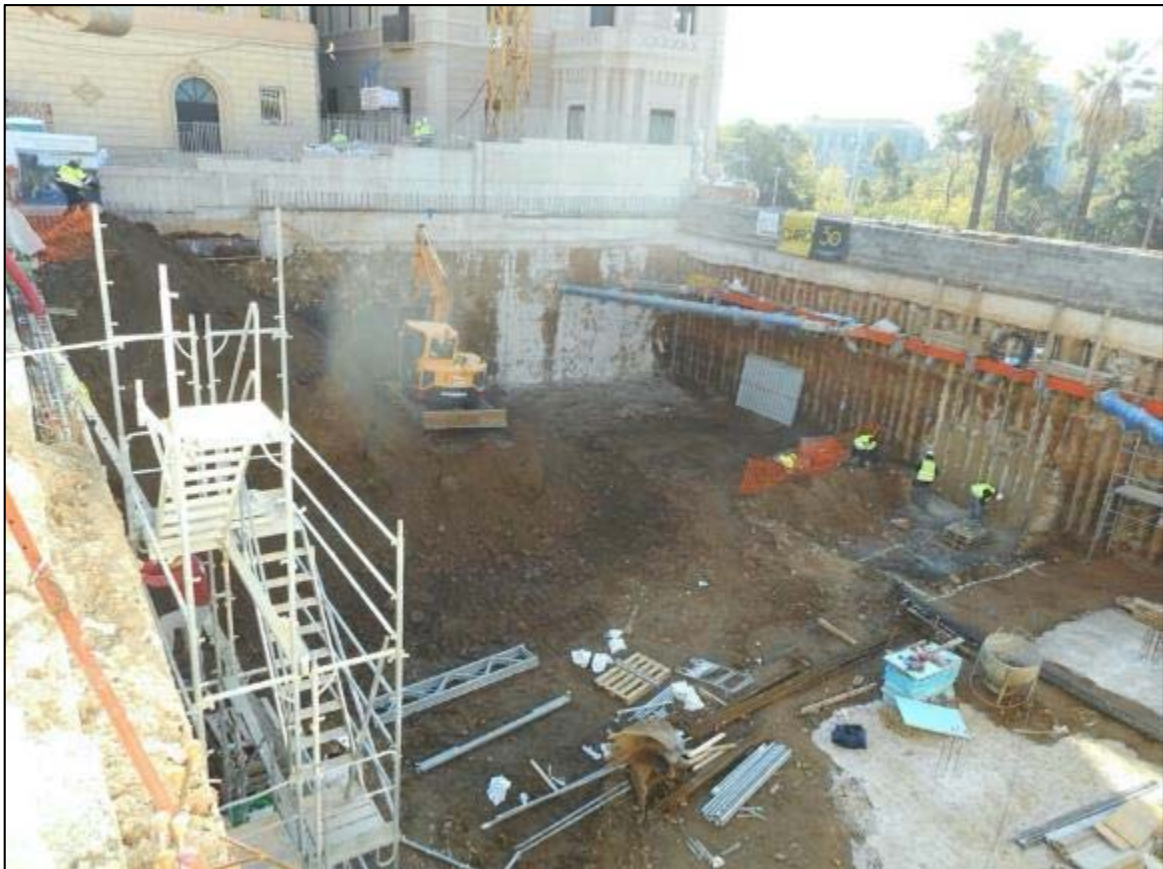
64. Tasques finals de rebaix de terreny de la tercera fase, orientació sud-oest.
