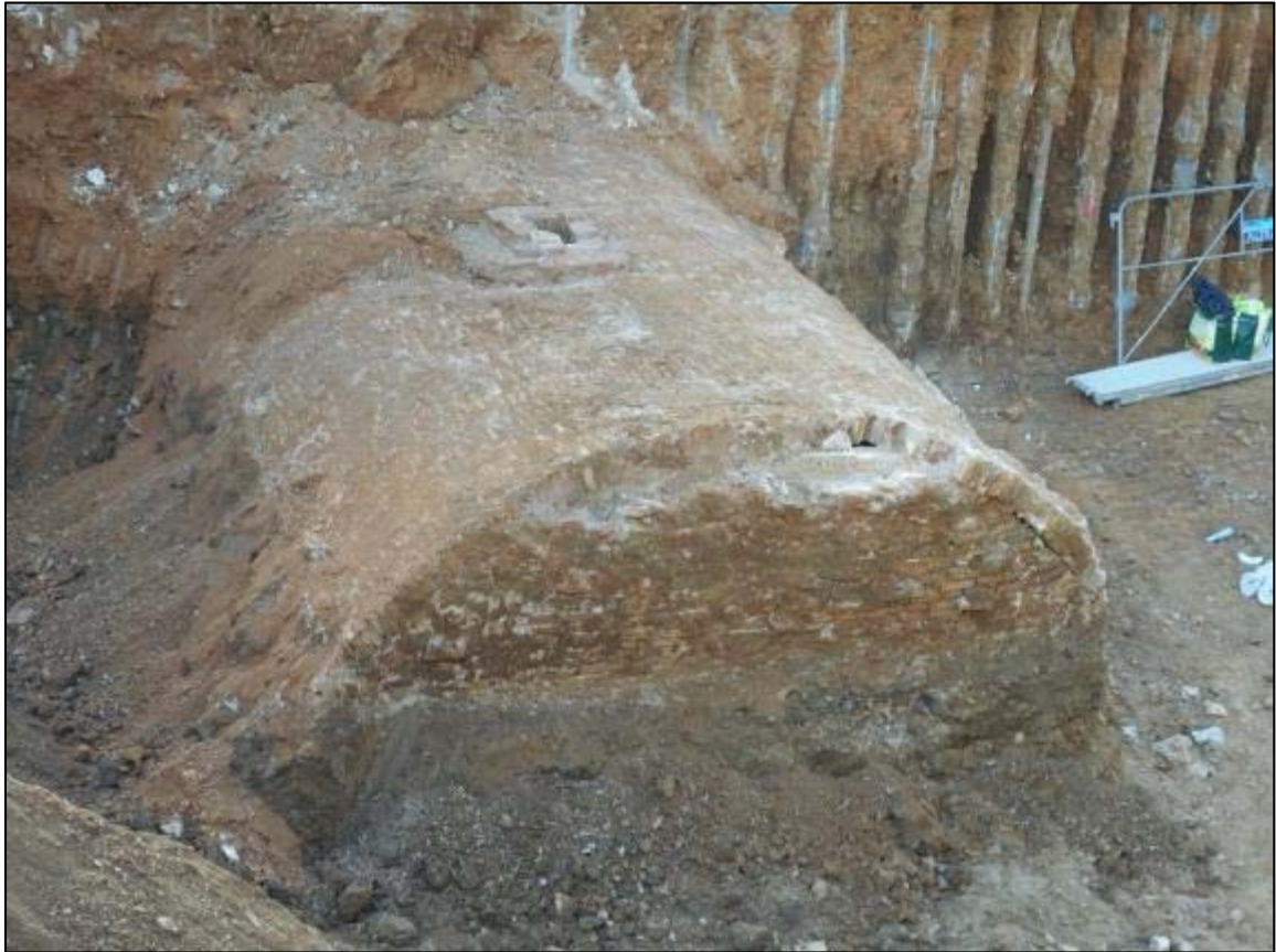
54. Detall de l'estructura UE 008, amb obertura superior (baixant-embornal).
