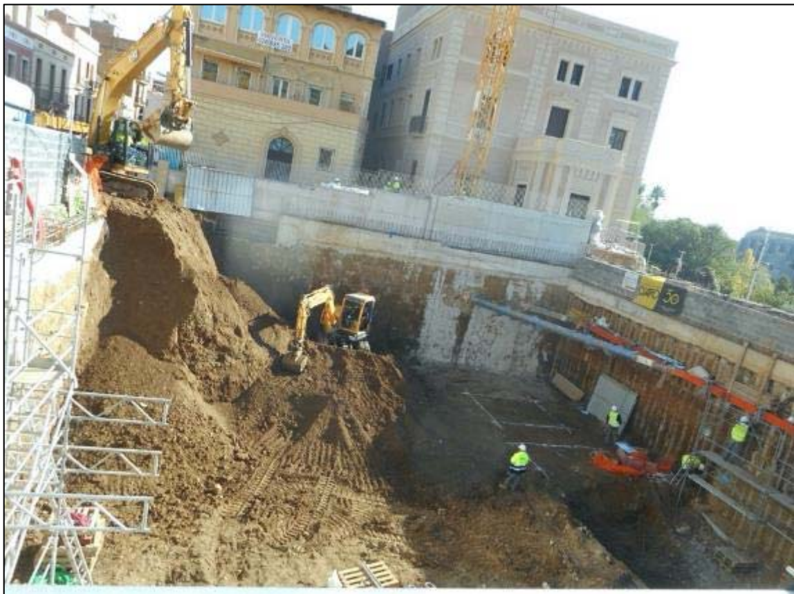
66. Tasques finals de rebaix de terreny de la tercera fase, orientació sud-oest.
