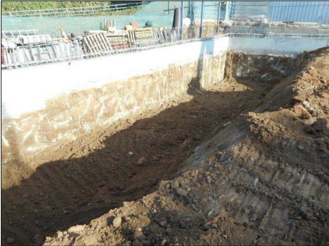
25. Treballs d'extracció de terres del solar en la segona fase, orientació nord.
