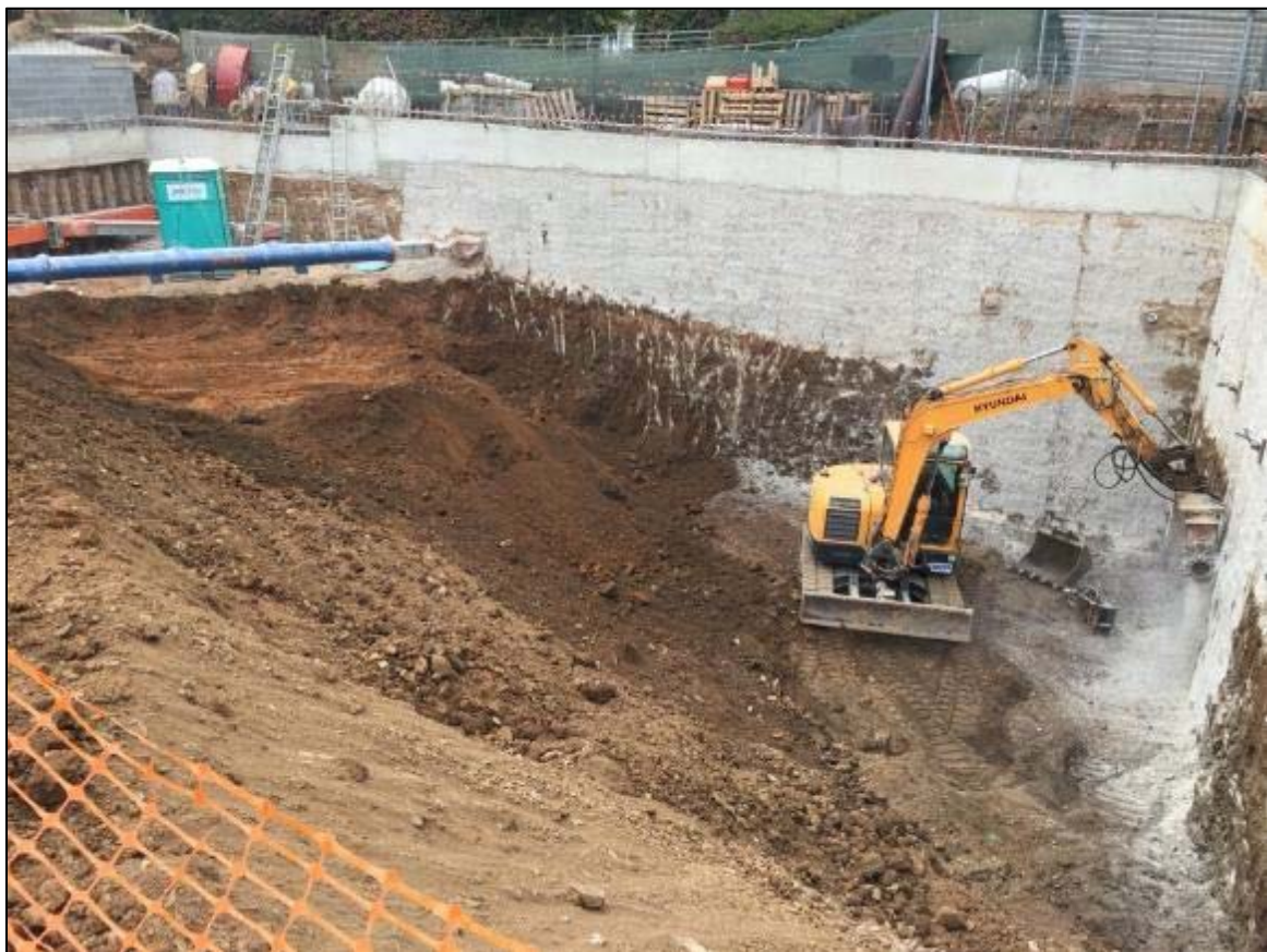
42. Tasques de rebaix de terreny de la tercera fase, orientació nord.
