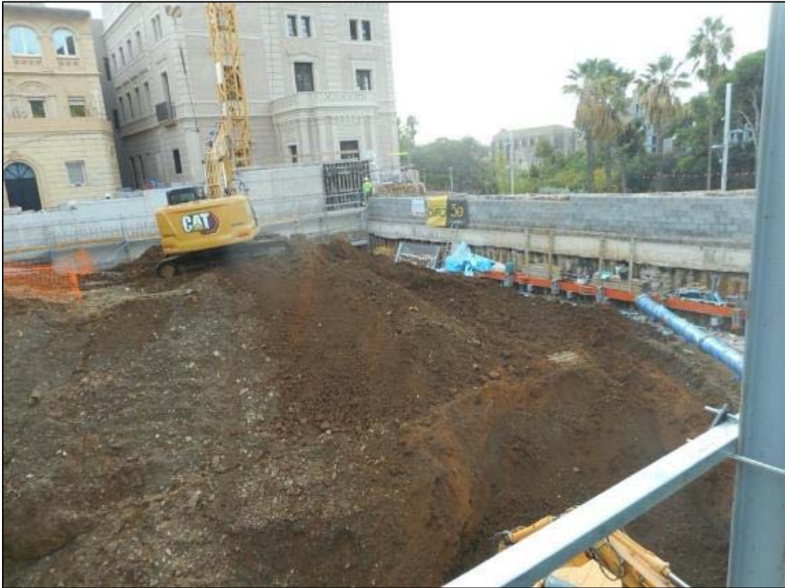
45. Tasques de rebaix de terreny de la tercera fase, orientació oest.
