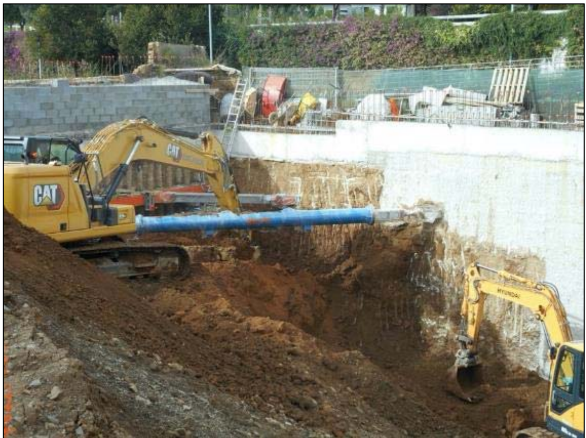
46. Tasques de rebaix de terreny de la tercera fase, orientació nord.
