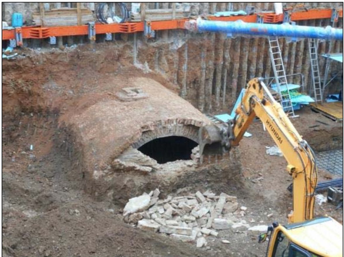
58. Tasques d'enderroc de l'estructura UE 008.
