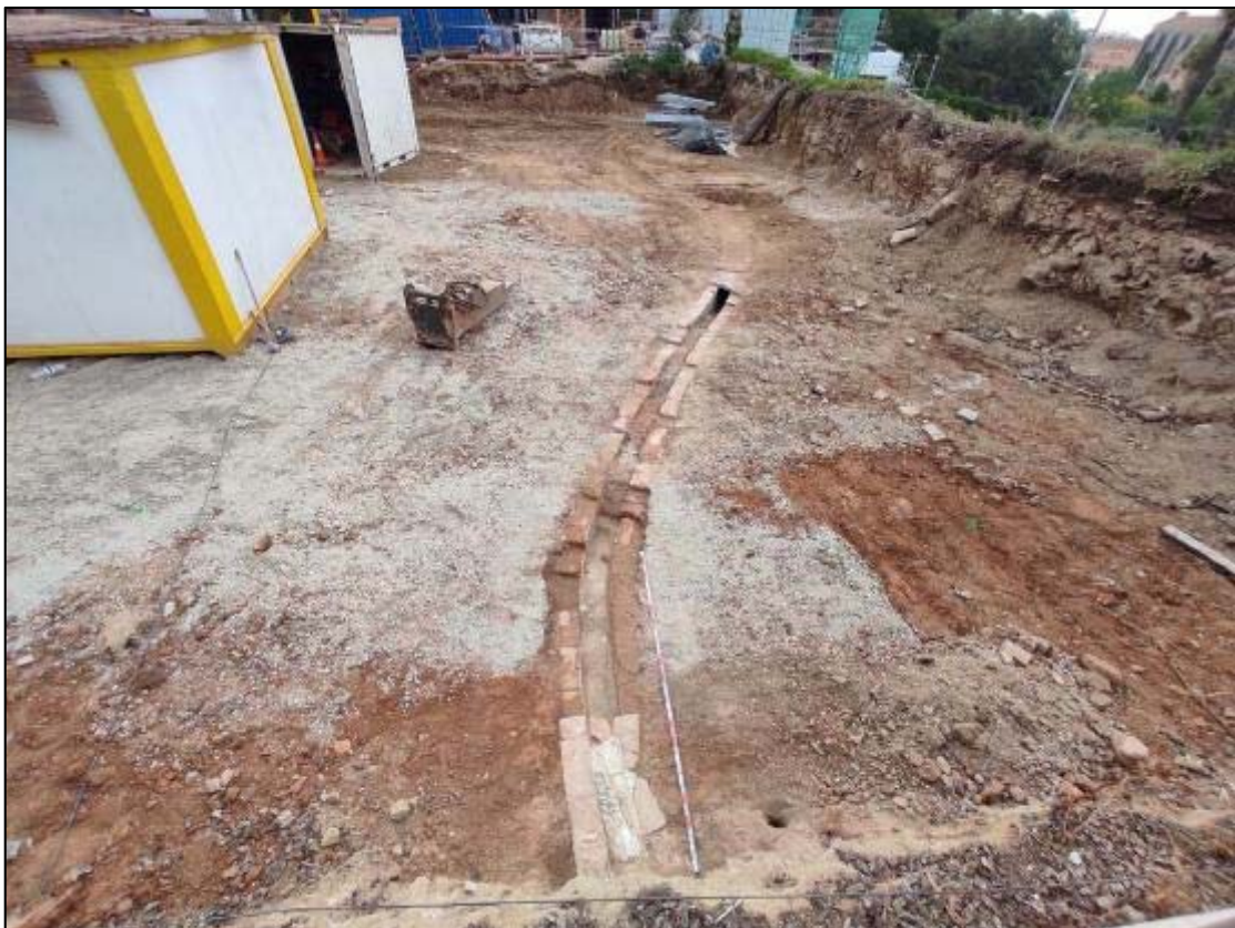
16. Panoràmica general final de la canalització (UE102), des de l'oest.
