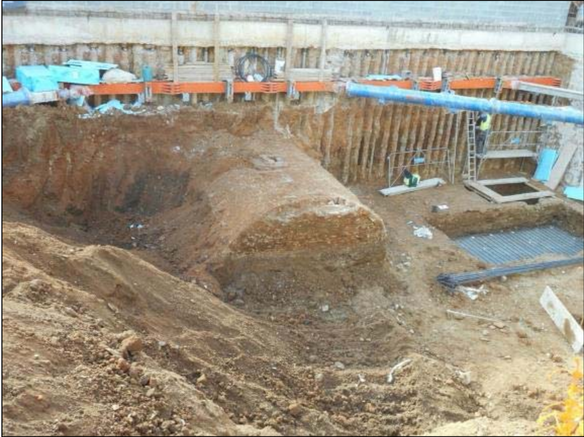
53. Vista general del solar amb l'estructura UE 008.
