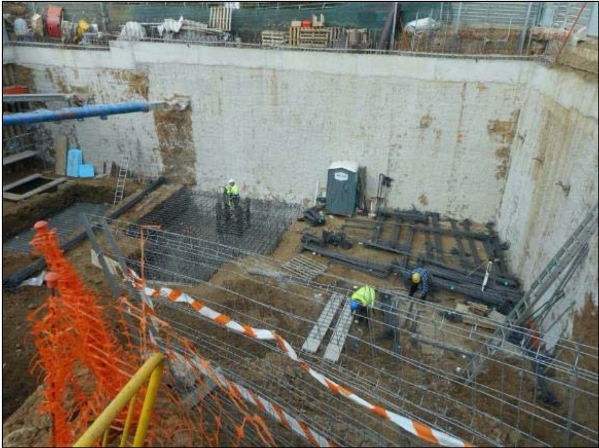
55. Tasques de rebaix de terreny de la tercera fase, orientació nord.
