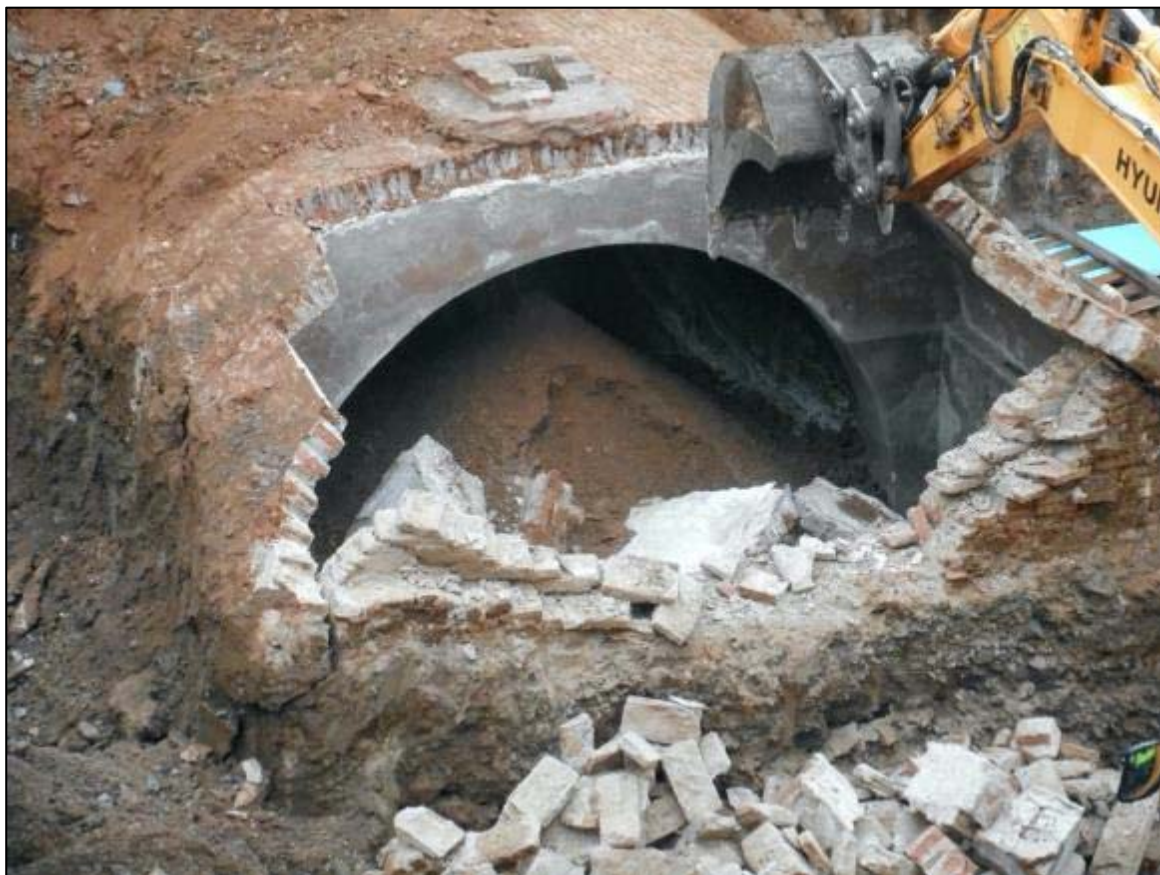
59. Tasques d'enderroc de l'estructura UE 008.
