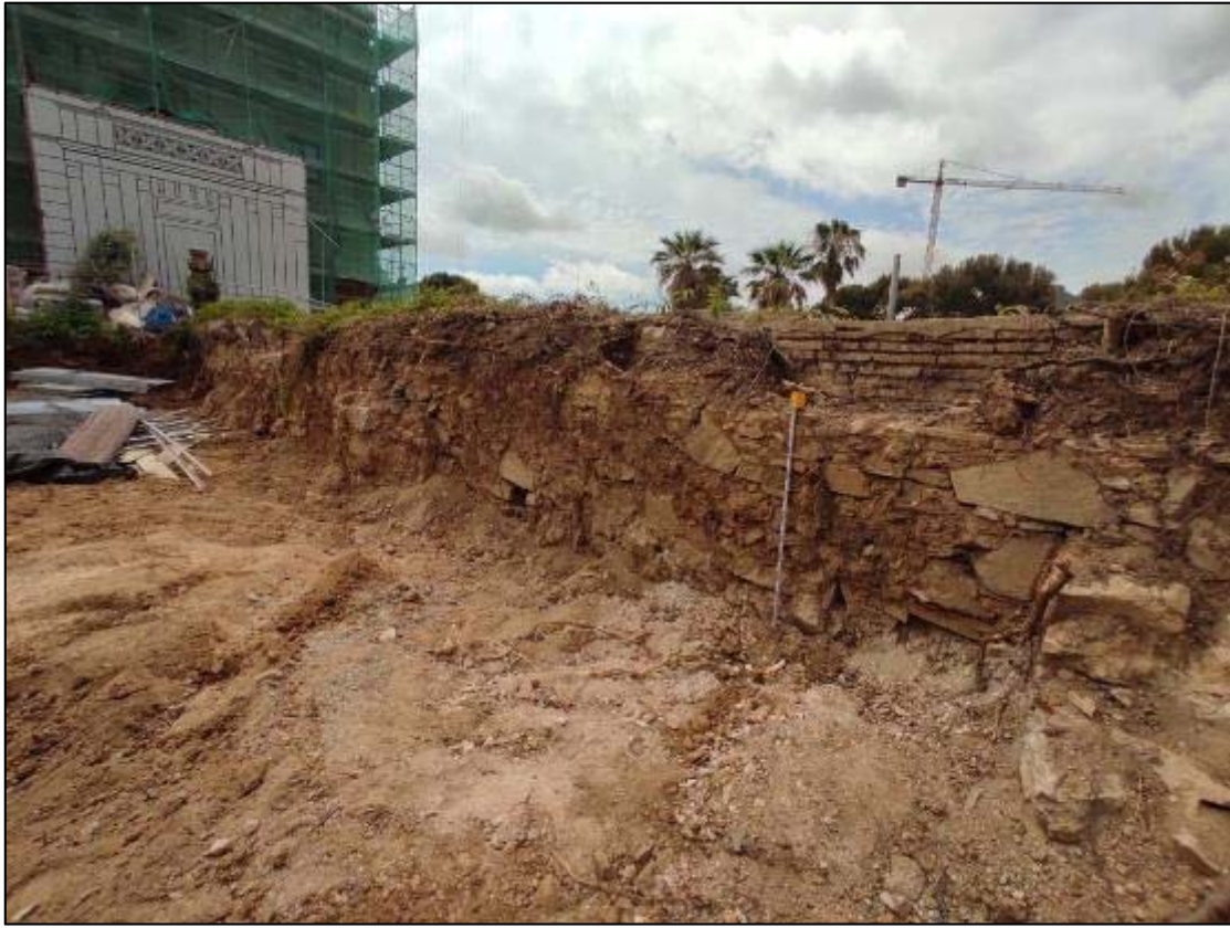
11. Imatge de la banda est del mur de contenció (UE107), des del nord-oest.
